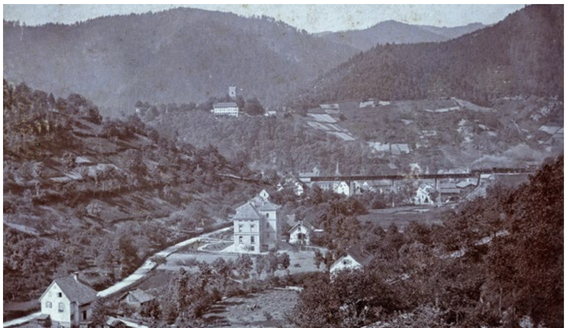
Hornberg um das Jahr 1893, hinten das Viadukt der Schwarzwaldbahn.
