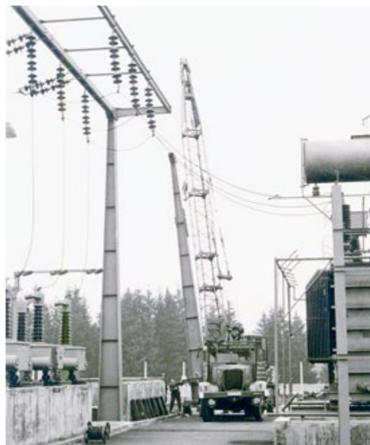
Bau des Umspannwerkes in Schönwald im Jahr 1957.
